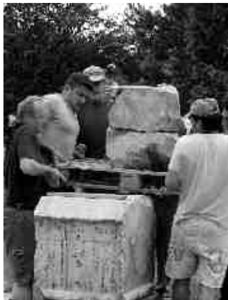
Instalace slunečních hodin na zámeckém nádvoří
